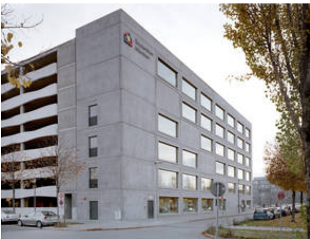
Hild und K Architekten, Bauzentrum München Riem, 2004, Foto: Gerrit Engel
