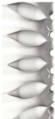
Detailausschnitt der Gebäudehülle
