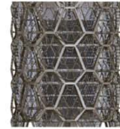
Detailausschnitt der Fassade
